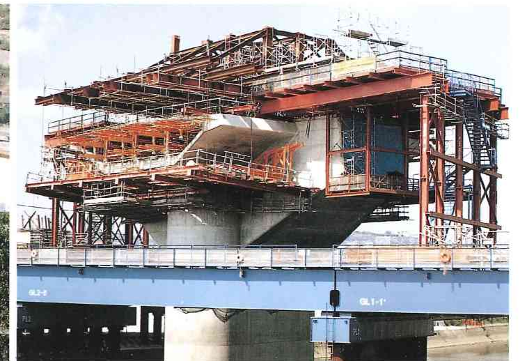
完成した柱頭部。
