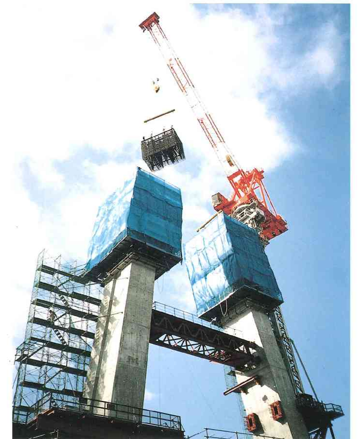
横ストラット設置後の斜柱部セルフクライミング施工状況。タワークレーンにより次のリフトの鉄筋ブロックを吊下げた状態。
