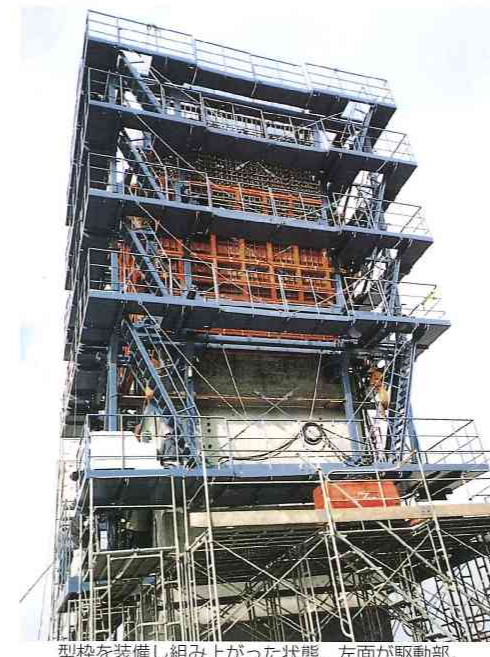
型枠を装備し組み上がった状態、左面が駆動部。
