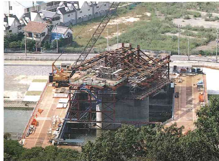
ピロン式吊り支保工で左右同時に施工された柱頭部。
